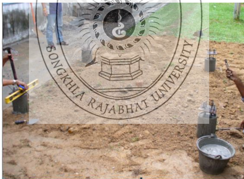
รูปที่ 3-4 แสดงการสร้างแป้นและเสาเพื่อรับโครงสร้าง
