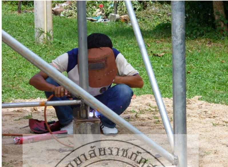
รูปที่ 3-7 แสดงการเชื่อมโครงสร้างกับรากฐานที่ดำเนินการไว้แล้ว
