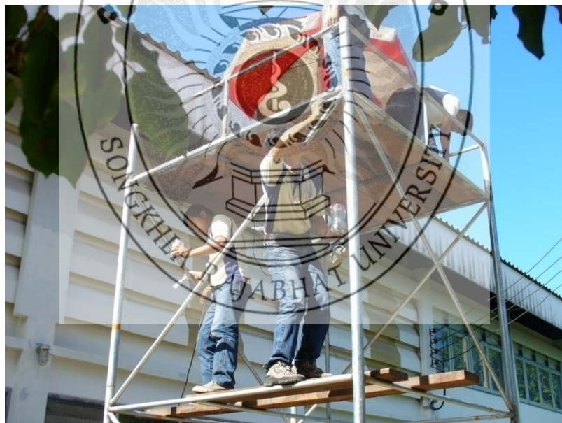
รูปที่ 3-8 แสดงการทาสีโครงสร้างเมื่อดำเนินการประกอบเสร็จ
