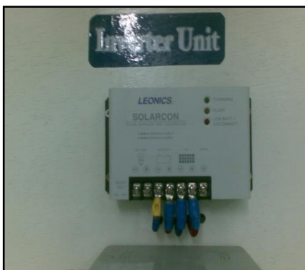
รูปที่ 3-18 แสดงการตรวจสอบและทดลองชุดชาร์จประจุแบตเตอรี่
