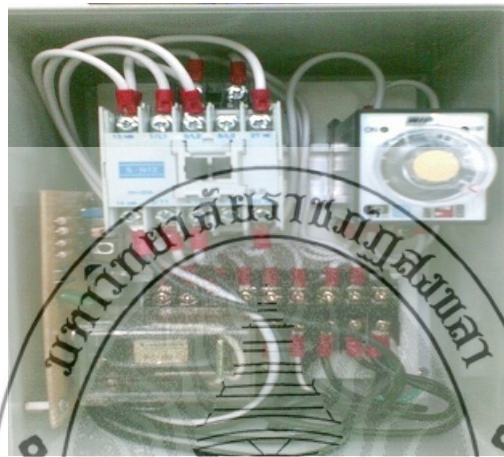
รูปที่ 3-21 แสดงการตรวจสอบและทดลองชุด ATS
