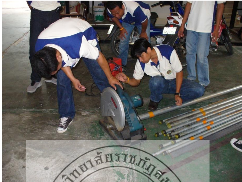
รูปที่ 3-5 แสดงการจัดเตรียมเหล็กโครงสร้างภายนอก
