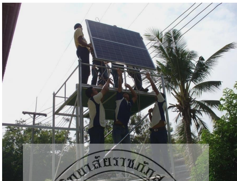
รูปที่ 3-11 แสดงการติดตั้งแผงโซลาร์เซลล์เข้ากับโครงสร้างที่สร้างไว้
