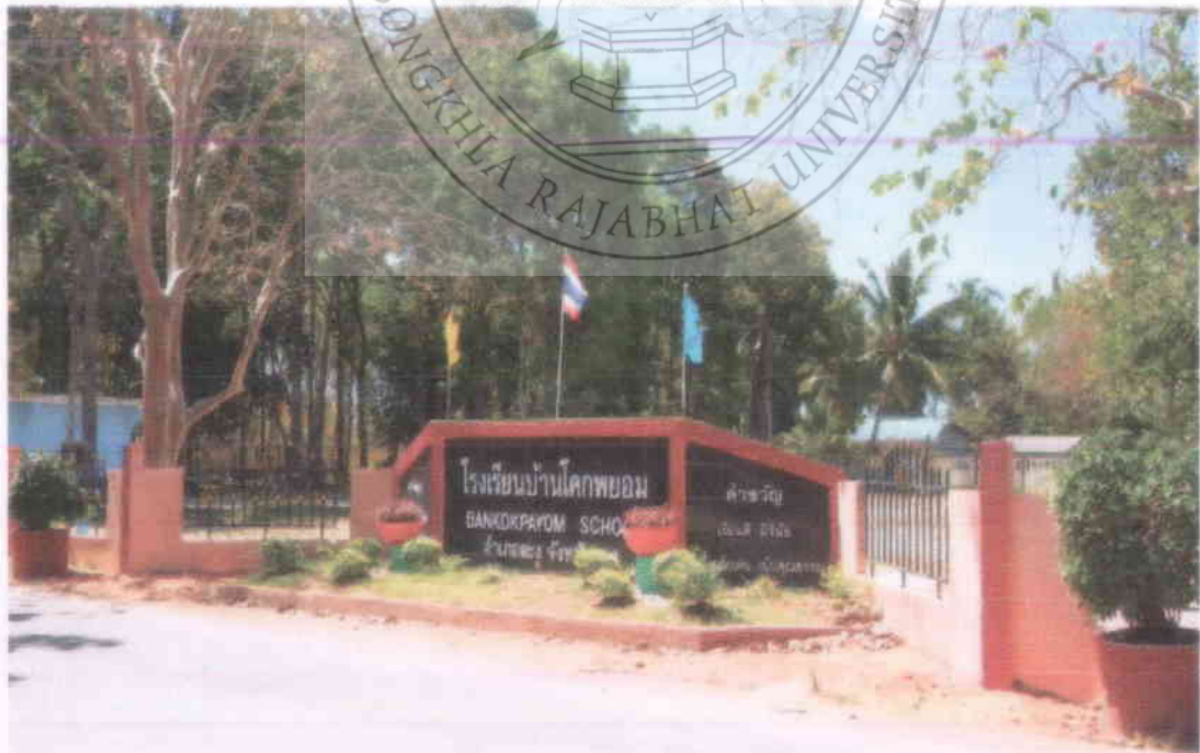
โรงเรียนบ้านโคกพะยอม ที่ตั้งอยู่ในพื้นที่บริเวณชุมชน รองรับลูกหลานชุมชนและพื้นที่โดยรอบ
