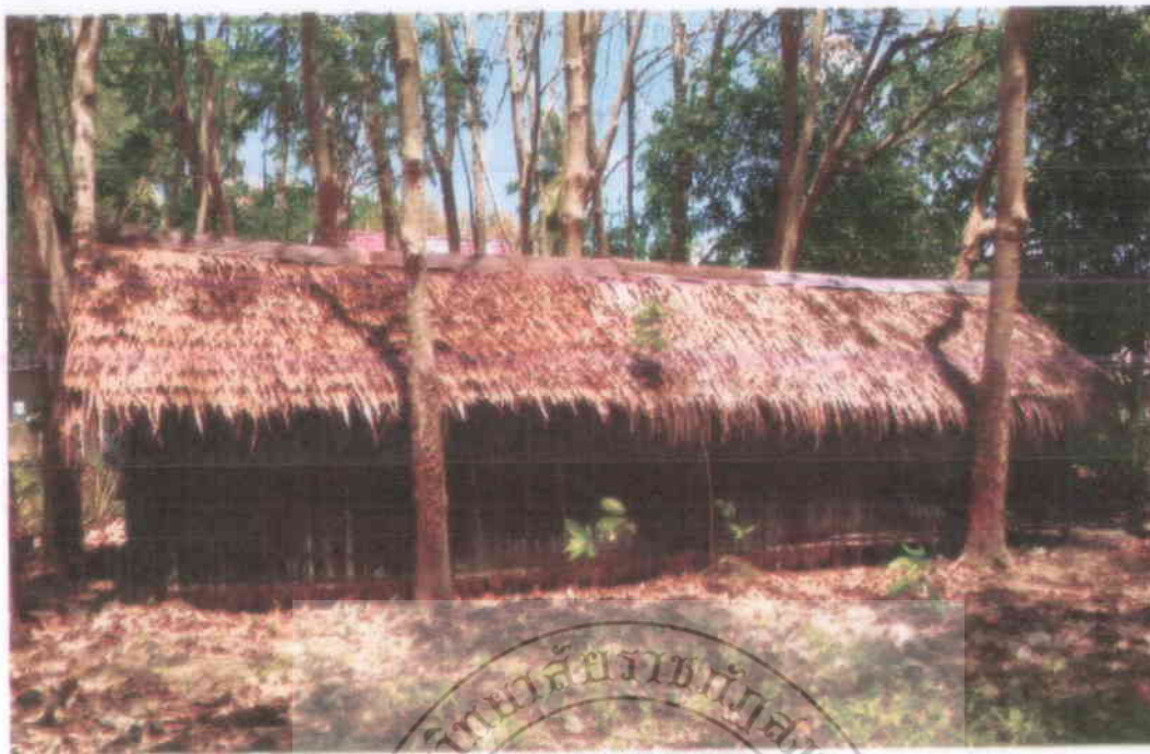
เรือนเพาะปลูกเห็ดของชุมชนบ้านโคกพะยอม
