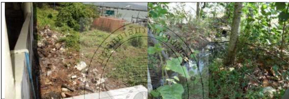
สภาพการก่อนติดตั้งบ่อดักไขมัน ณ วัดแหลมพ้อ
