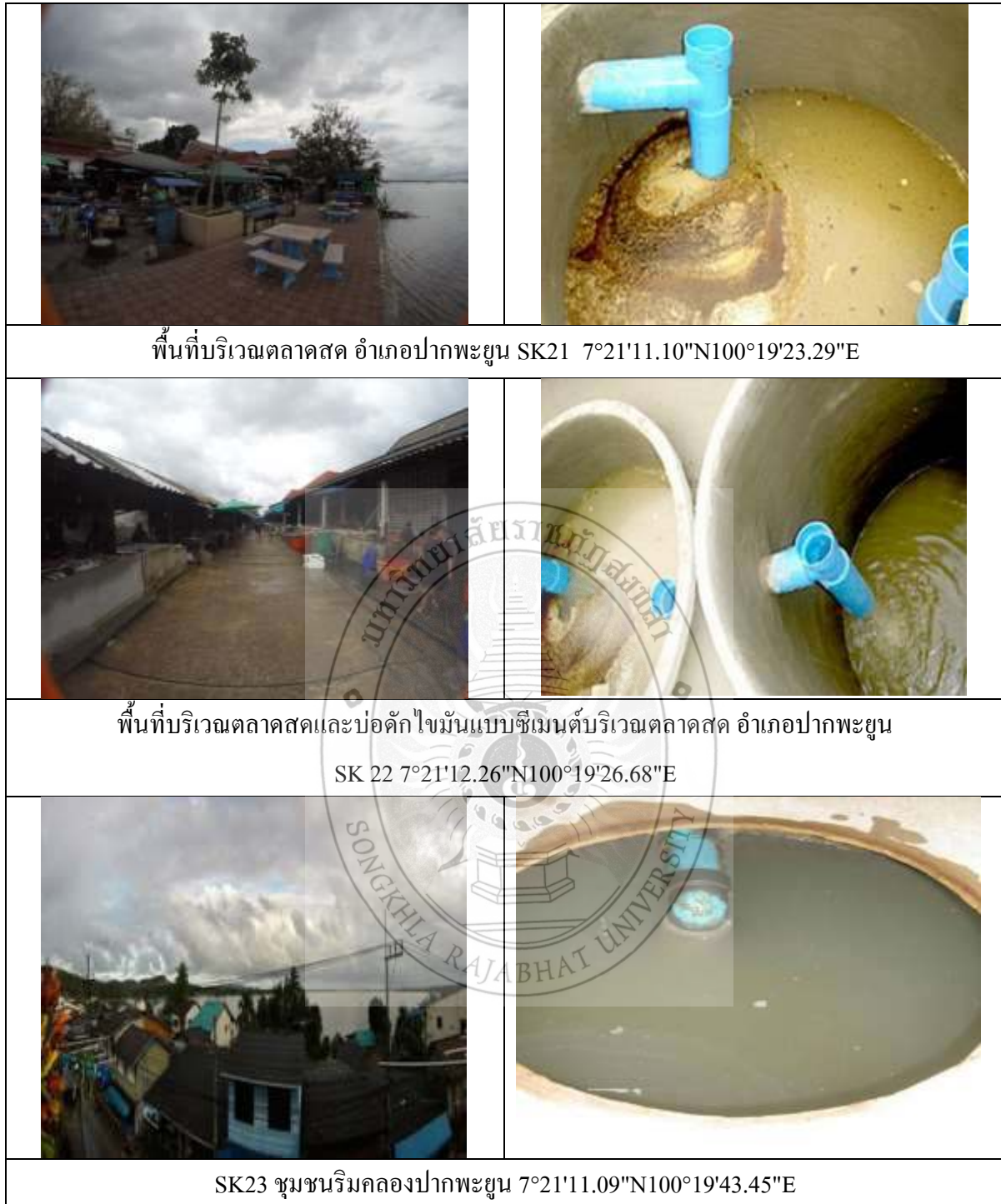
รูปที่ 4.4 พื้นที่ SK2 บริเวณตลาดสดและบ่อดักไขมันแบบซีเมนต์บริเวณตลาดสด อำเภอปากพะยูน
