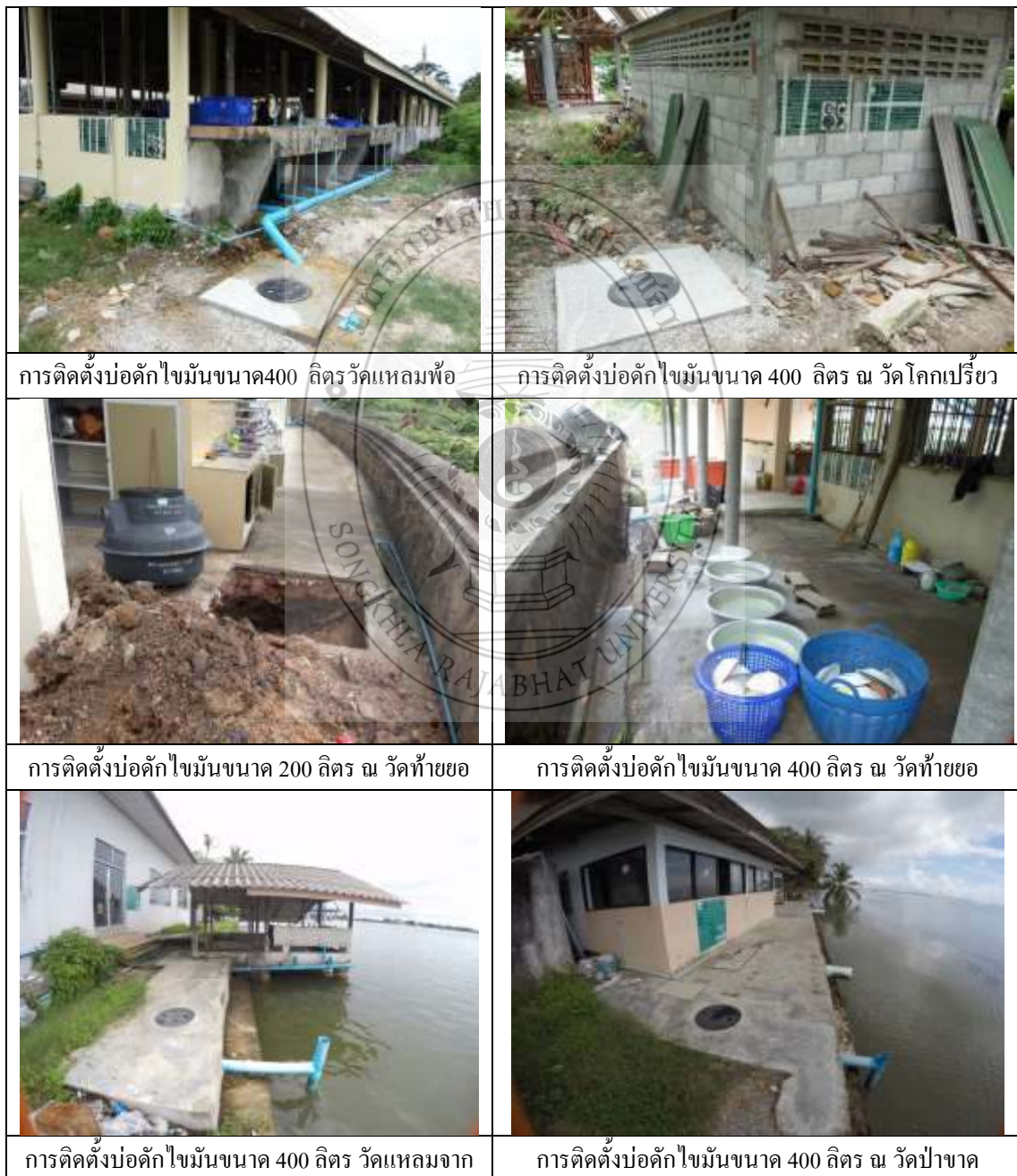
รูปที่ 4.18 การติดตั้งบ่อดักไขมันนําร่อง ณ พื้นที่ทะเลสาบตอนกลางและตอนล่าง
