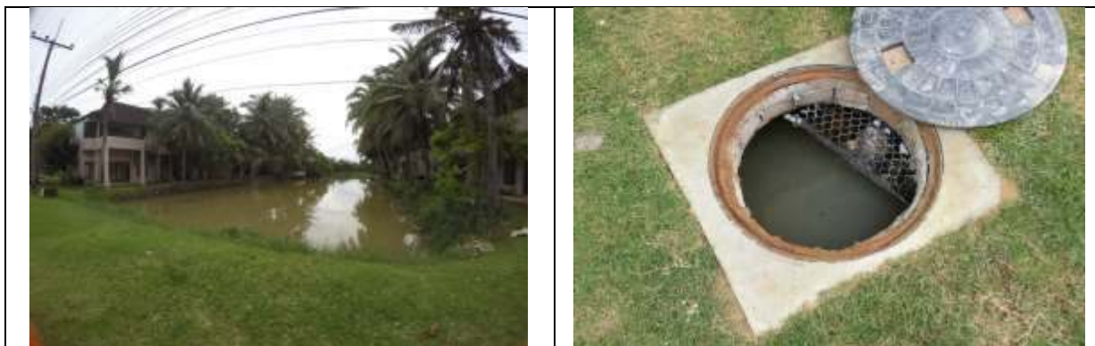
บริเวณครัวเรือนที่มีการติดตั้งบ่อดักไขมันรึมน้ำSK41 หมู่บ้านสงขลาถาถา
