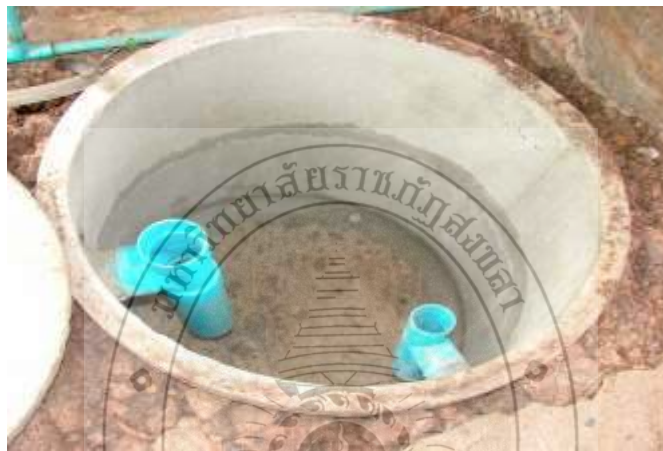
รูปที่ 2.4 แสดงถังดักไขมันแบบวงขอบซีเมนต์
