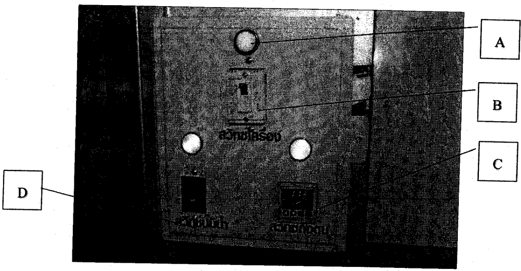
ภาพที่ 3.9 ตู้ชุดควบคุมระบบ
