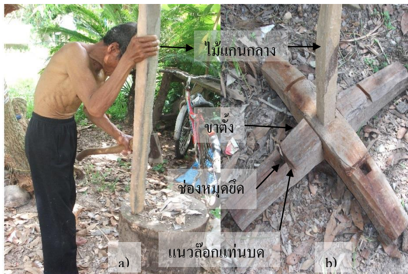
รูป 3.6 การทำโครงสร้างหลักของครกสี ซ้ายมือเป็นการใช้ขวานถากท่อนไม้เพื่อทำไม้แกนกลาง ขวามือเป็นฐานตั้งกากบาทโดยมีไม้แกนกลางเป็นตัวยึด
