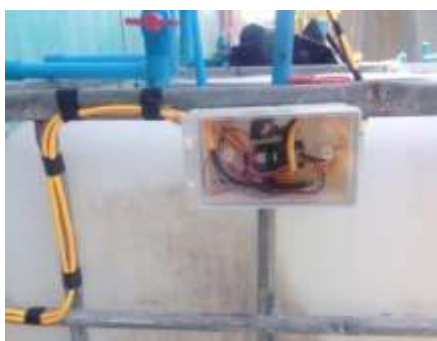
ภาพที่ 3-18 การติดตั้งชุดตรวจจับวัดอุณหภูมิ
