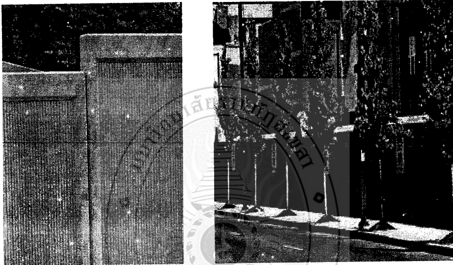
(ก) กำแพงกันเสียงประเภทคอนกรีต (ข) กำแพงกันเสียง Brick Block
