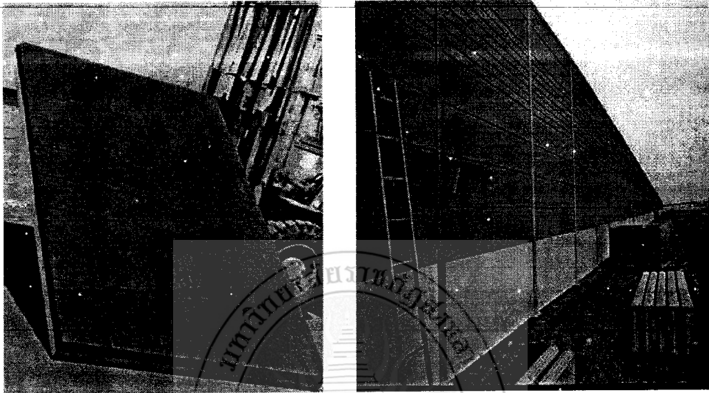
(ก) กำแพงกันเสียงประเภท Recycled Rubber (ข) กำแพงกันเสียงประเภท วัสดุผสม
