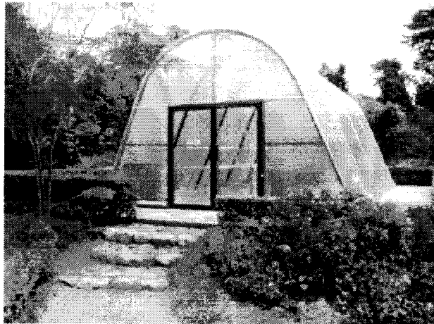
ภาพที่ 2.3 เครื่องอบแห้งแบบรับแสงอาทิตย์โดยตรง ชนิดอุโมงค์หลังคาโค้ง
