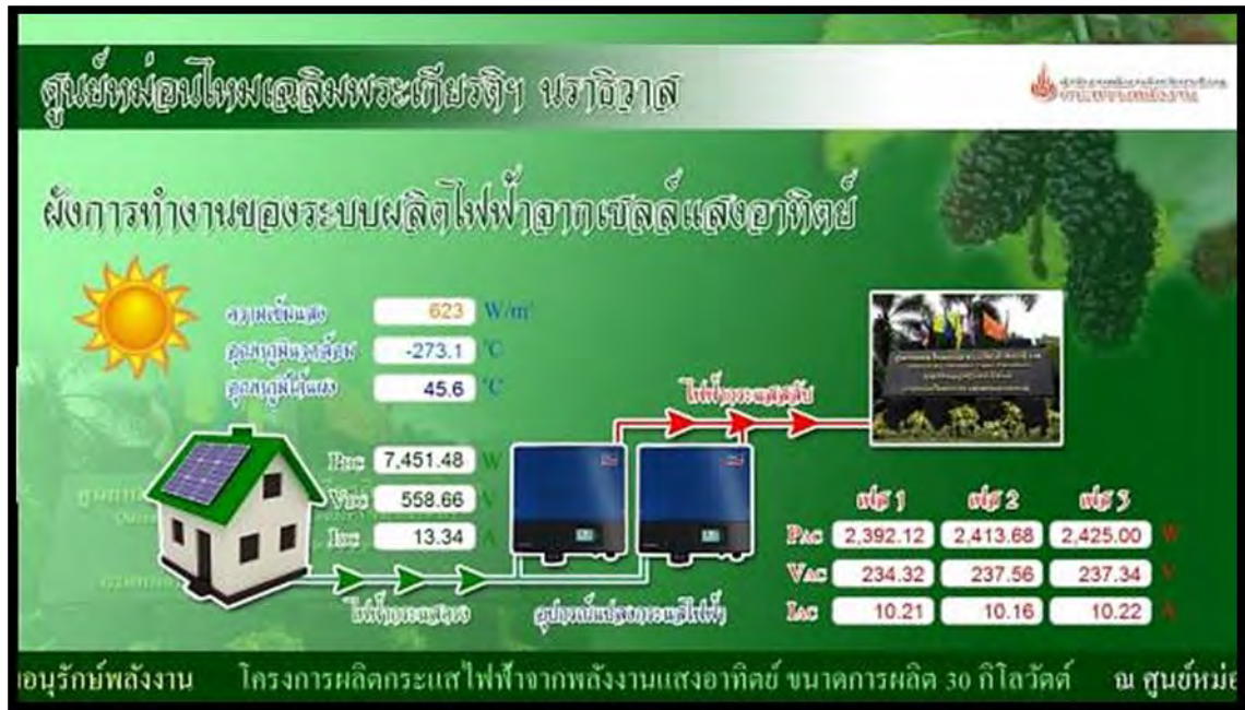
ภาพที่ 6-42 ตัวอย่างการแสดงผล Solar display system ของระบบ ณ ศูนย์หม่อนไหมเฉลิมพระเกียรติฯ นราธิวาส
