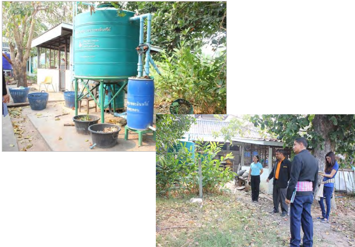
ภาพที่ 6-26 ถังหมักก๊าซชีวภาพจากขยะอินทรีย์ (ถังเดิม) และตำแหน่งที่จะดำเนินงานโครงการ (ปัจจุบัน)
