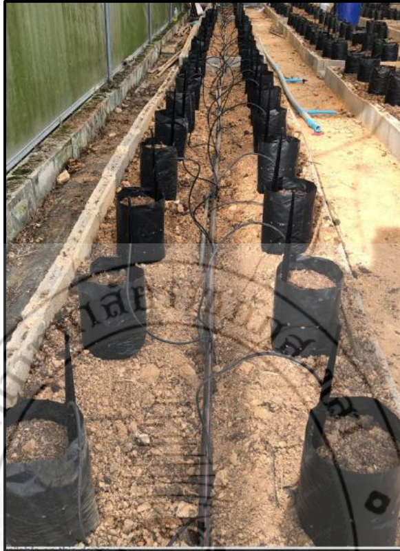
ภาพที่ 4.23 วิธีการเดินท่อระบบน้ำและปุ๋ยอัตโนมัติ
