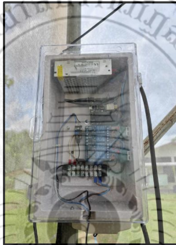
ภาพที่ 4.22 ตัวอย่างการติดตั้งกล่องควบคุมในโรงเรือน
