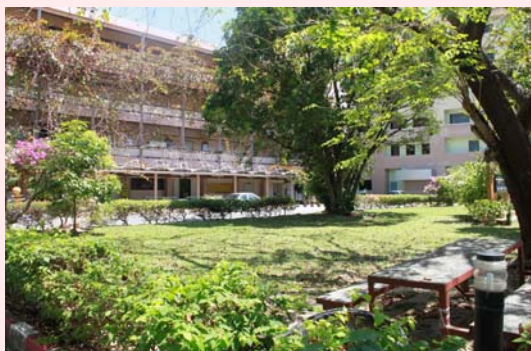
ภาพก่อนปรับปรุง
