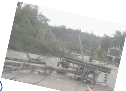
ถนนทางเข้าประตู 1
